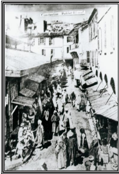
Fig.110 : Vue sur une ancienne rue commerçante à Constantine
