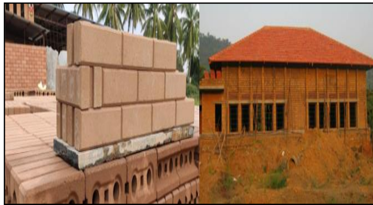
Figure I.5: Fabriquer des constructions en Blocs de terre compactée (Sources Internet)
