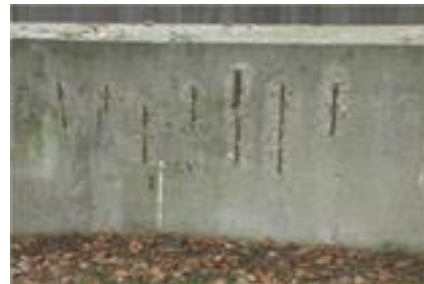
Figure 15 : Dégagement des armatures corrodées [57]
