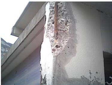
Figure 15 : Dégagement des armatures corrodées [57]
