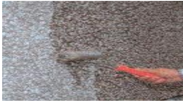
Figure 14 : L'imprégnation du béton au rouleau, à la brosse ou par projection du liquide [56]
