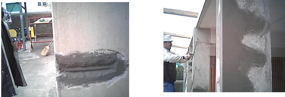
Figure 16 : Réfection des bétons à l'aide de mortier [57]
