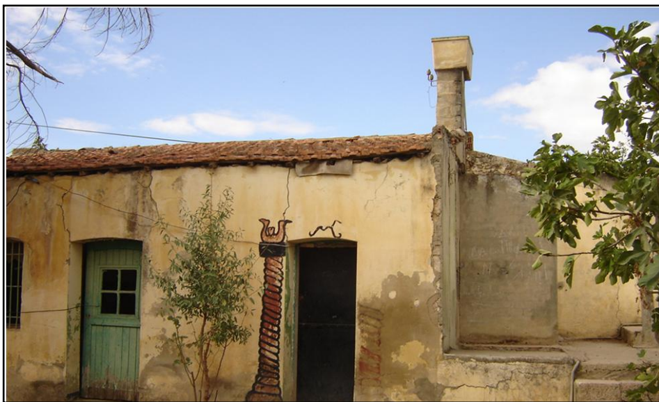
Photo n° 27 : La caserne de l'époque coloniale.
