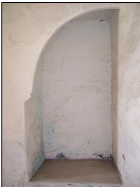
Planche N° 22 : Source Photos, auteur, 2010.
