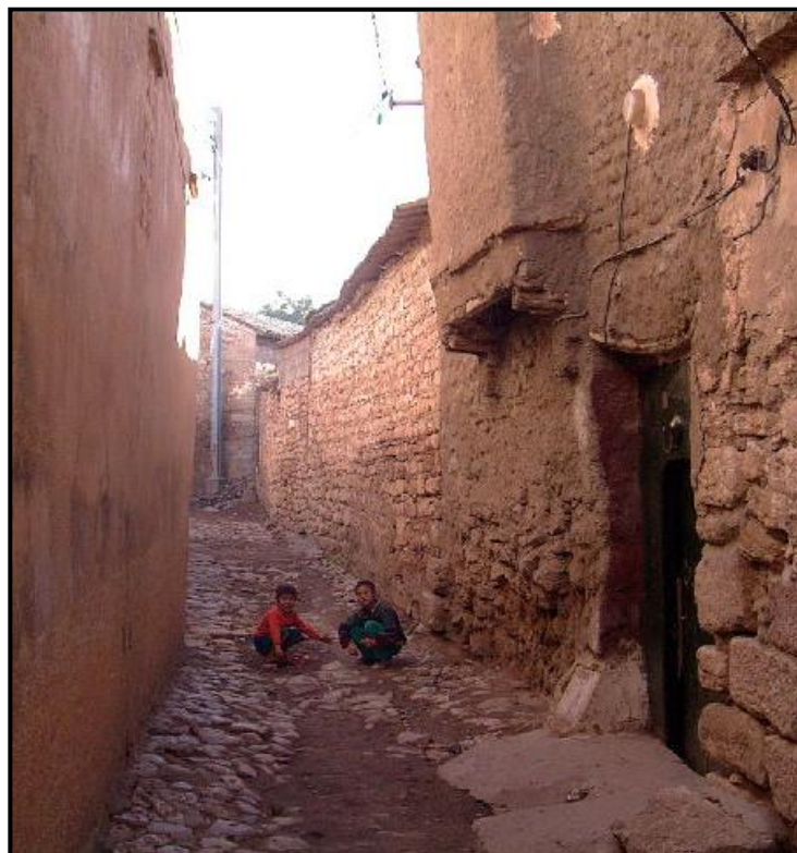
Planche N° 10 : Source Photos, auteur, 2010.
