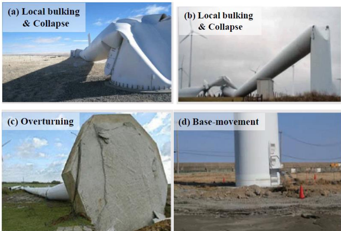
Figure 1. 14. Dommages causés aux éoliennes par des événements extrêmes(Liu, Lei et al. 2024).
