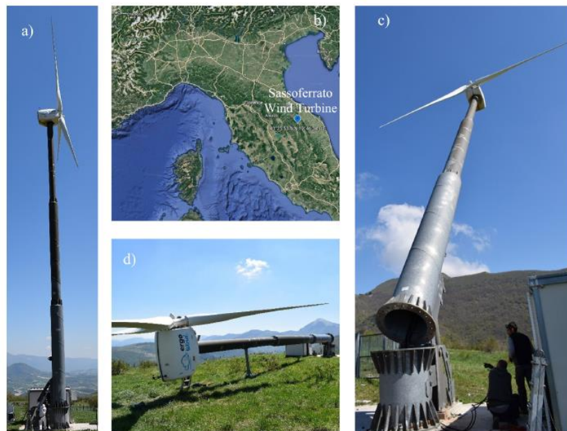
Figure 5.2. Éolienne de Sassoferato : a) Tour en état de fonctionnement ; b) Emplacement ; c) Système de pliage contrôlé ; d) Tour en cours de maintenance.
