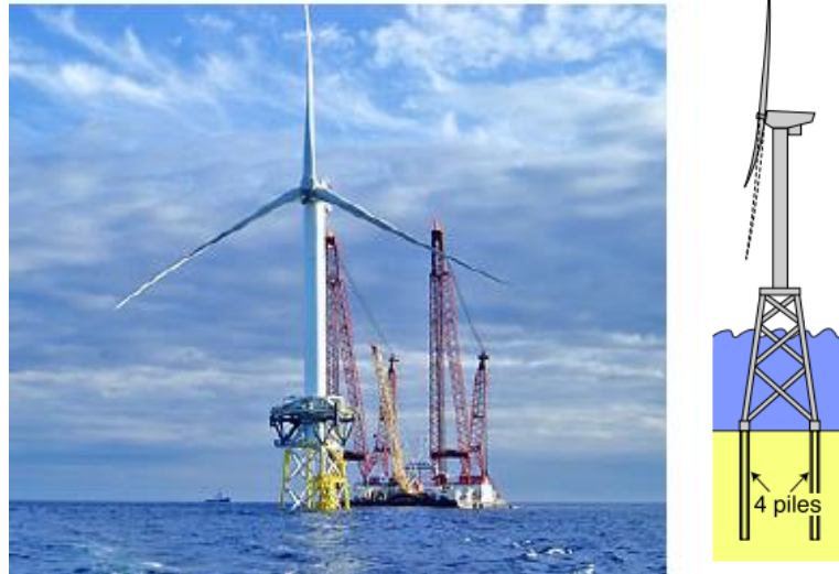
Figure 1.12. type fondation en jacket
