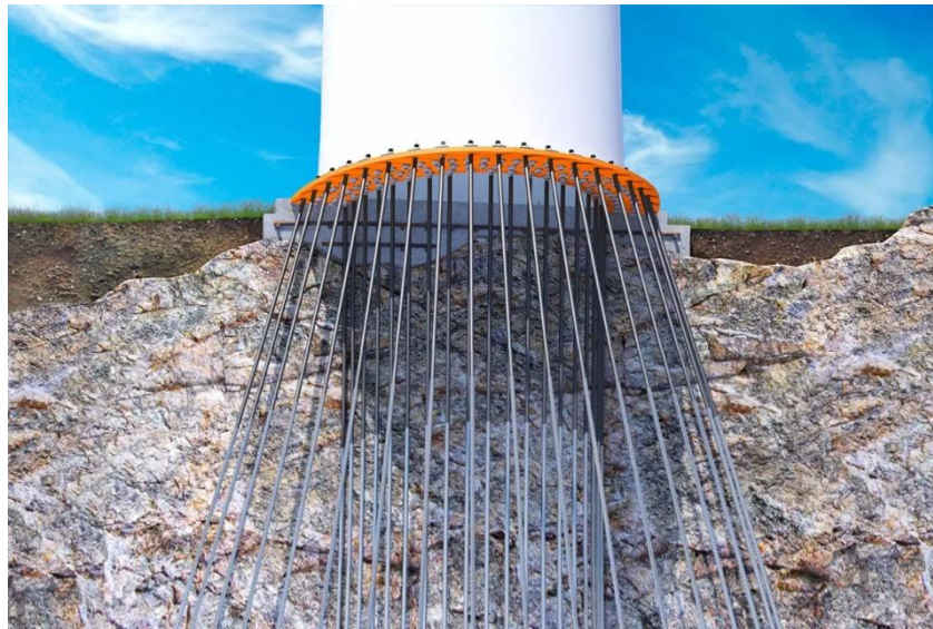
Figure 1. 7. Fondation encré dans le roc
